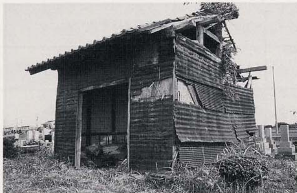
写真1 西御堂の火屋（土本典生撮影）
