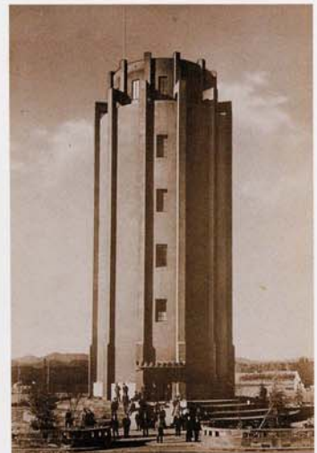
配水塔 (昭和12年完成、文京2丁目)
