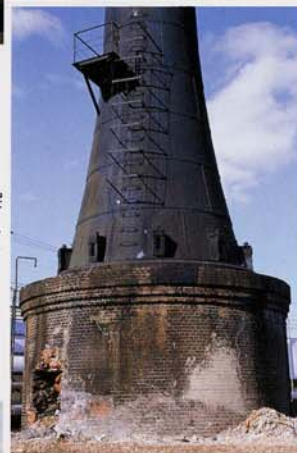
鋼製耐震煙突 (明治41年完成、羽衣2丁目)
