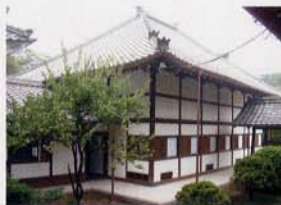
修理後の禪堂外観
