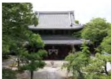
妙興寺仏殿(大和町)
