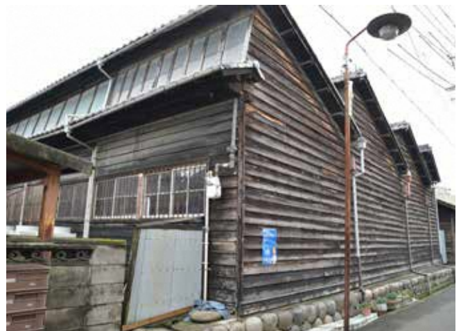
北側から見た高窓のあるのこぎり屋根の①工場。奥（写真右手）には下見板張りの⑧原系倉庫と⑨倉庫が連なる。
