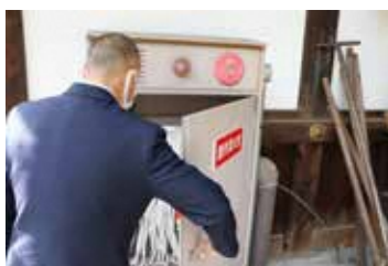
防火設備の点検
