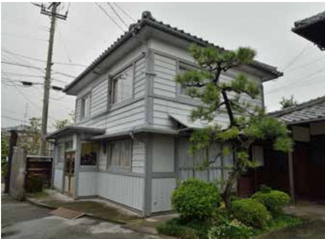
横板を重ねた「下見板張り」の洋風の外観が特徴の②事務所。2階の座敷には床の間もあり、和洋折衷となっている。
