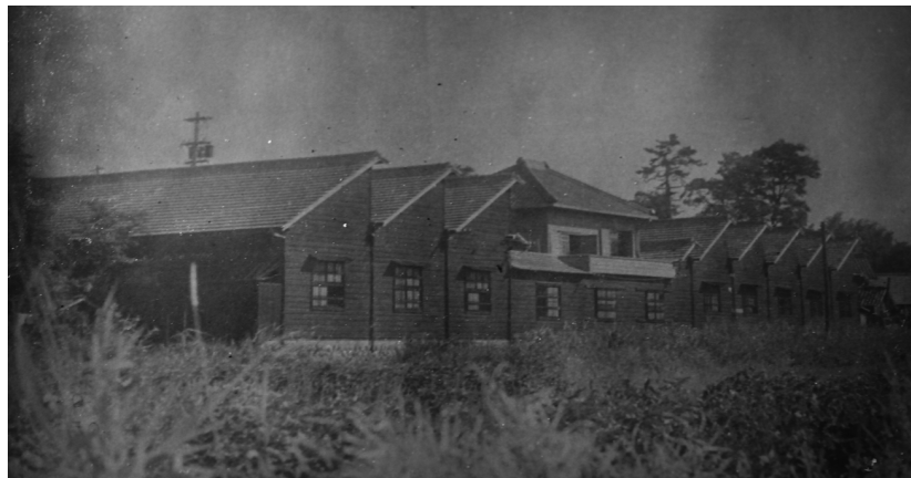
工場 南棟・事務所・北棟 (南面及び東面) 昭和26年6月撮影 個人蔵
