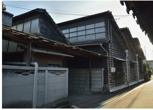
工場 南棟 (北面及び西面) 令和4年12月18日撮影
