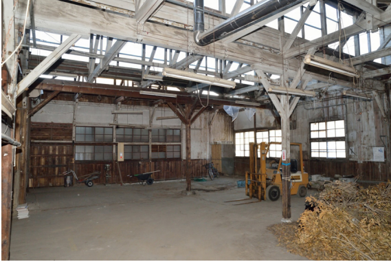
工場 南棟 内部 令和4年12月18日撮影
