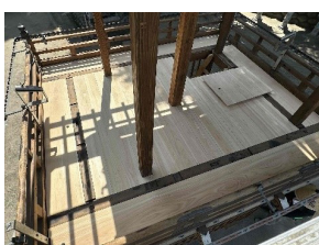
床板(修理後・2の山)
