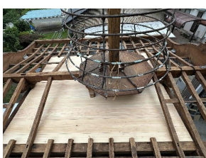
床板(修理後・3の山)
